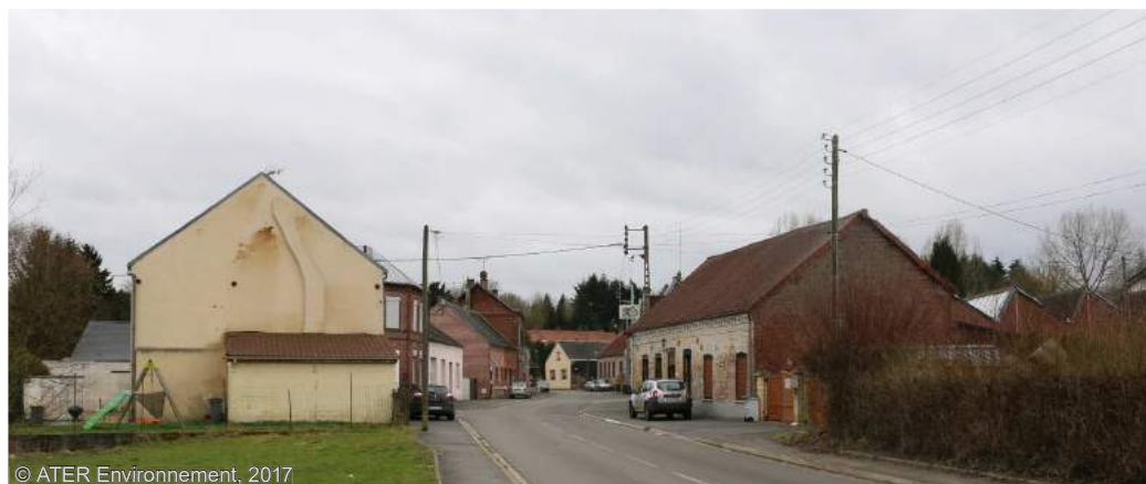
Fig. 163 : Vue depuis la D7761 à l'Est de Saint-Souplet
