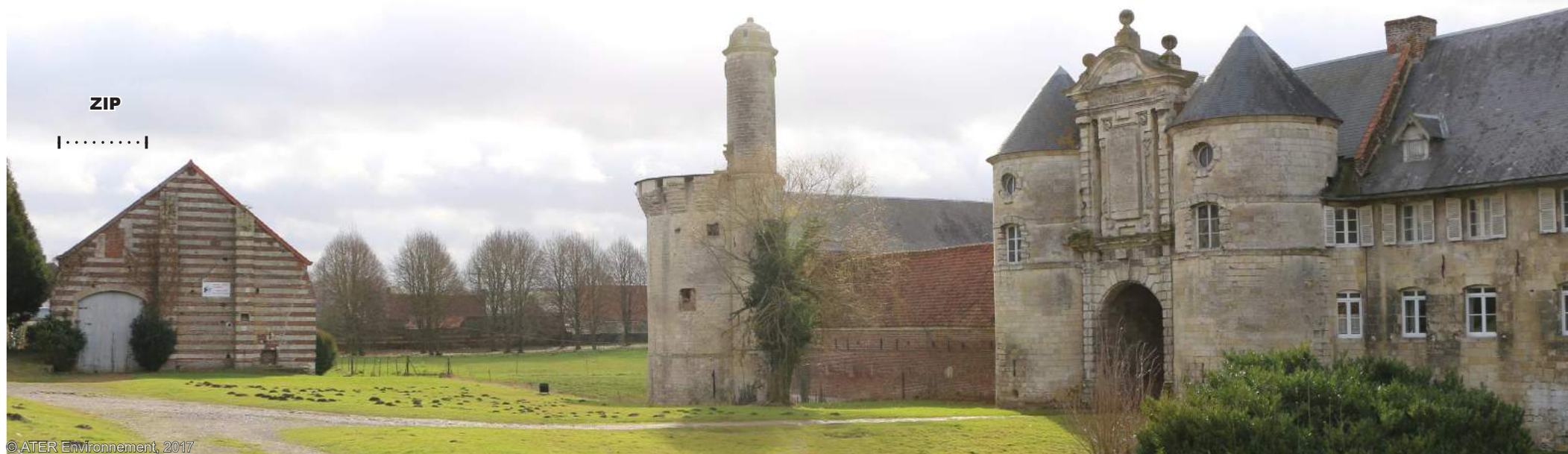
Fig. 91 : Vue depuis le Château d'Esnes
