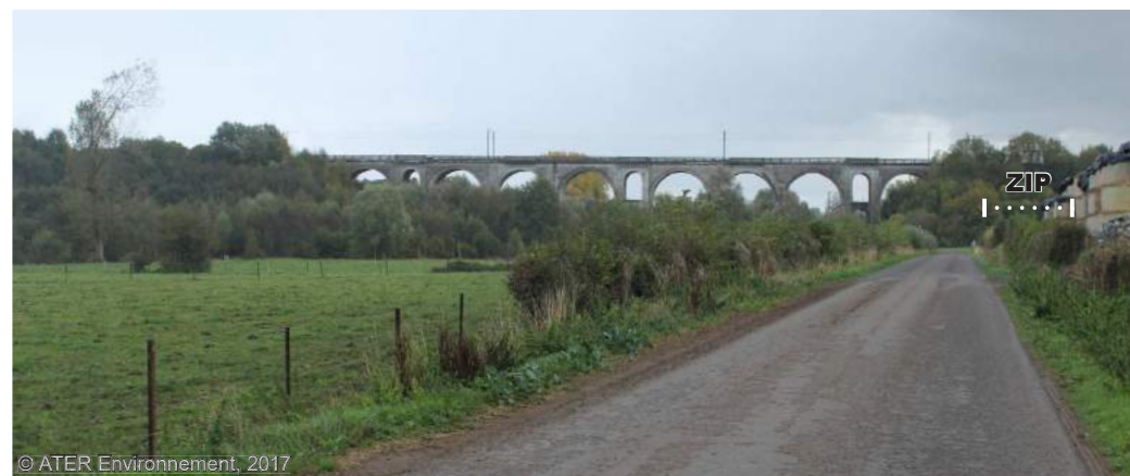
Fig. 141 : Viaduc entre Le Cateau Cambrésis et St-Benin
