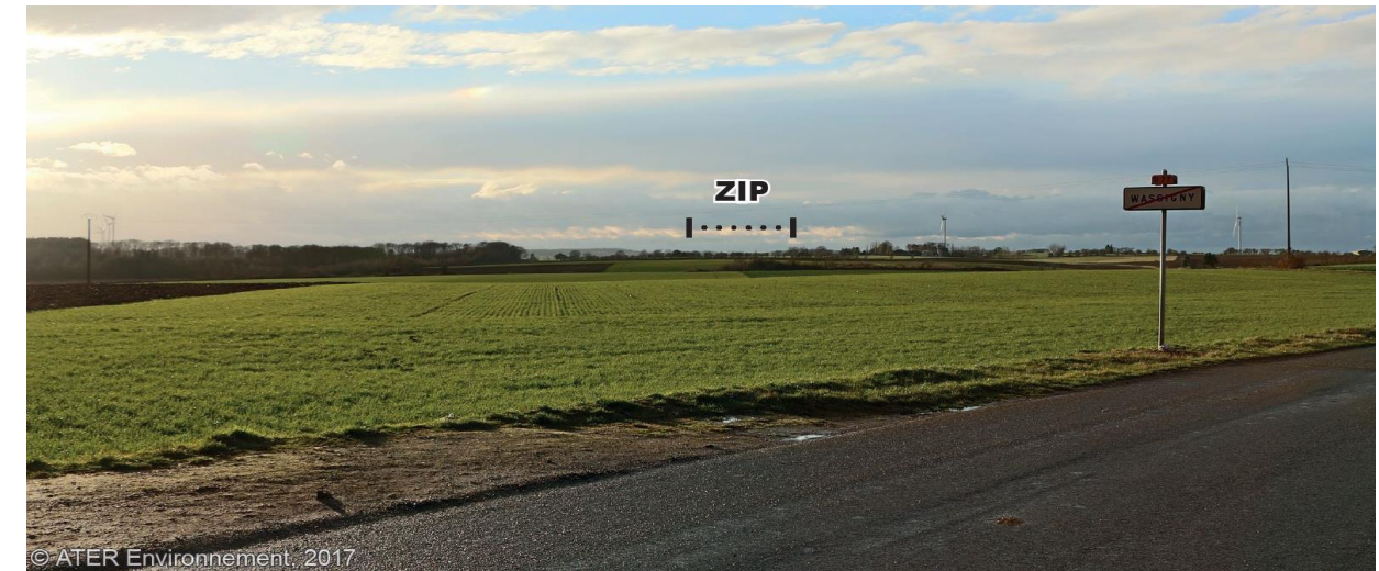
Figure 18 : Vue depuis la sortie de bourg Ouest de Wassigny (source : ATER Environnement, 2017)
