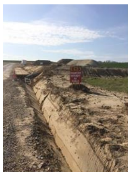
Tranchée pour la pose de câbles
