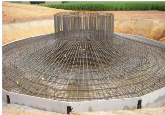
Photo 2 : Excavation et préparation de l'armature
